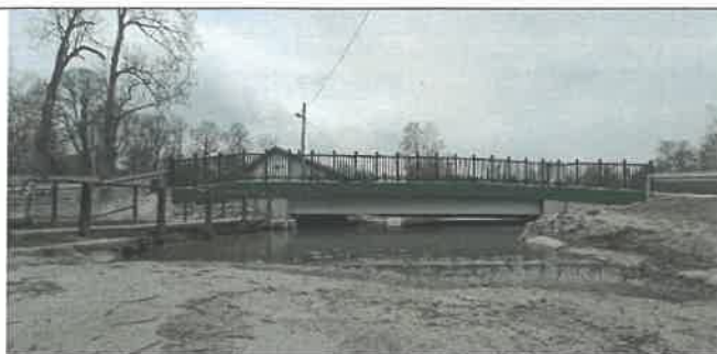
Odbudowa mostu na rzece Szreniawa w miejscowości Pławowice
