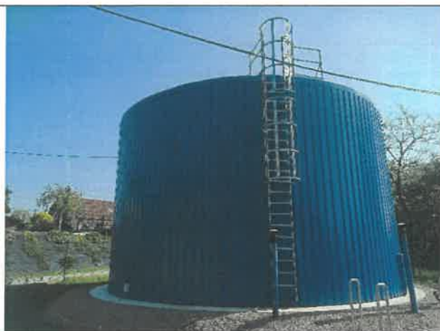
Budowa zbiornika wody pitnej o pojemności 300 m 3 na stacji uzdatniania wody w Nowym Brzesku
